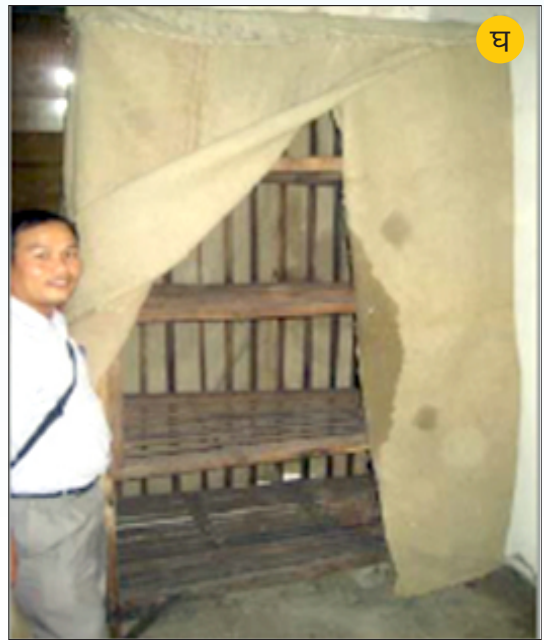
चित्र २४ : ईटाको पर्खाल र बाकस प्रकृतिको बाष्पिकरणिय चिस्यान (EC) क) ईटाको पर्खालको बाष्पिकरणिय चिस्यान ४.५ X २.५ X ०.६ मी लम्बाई, चौडाई र उँचाई, १५ - २० से.मी. ओसिलो दोहोरो पर्खाल (ख) भिजाएको बोराले छोपेको (ग) बाष्पिकरणिय चिस्यान भित्र राखेका तरकारीको अवस्था । घ) बाकस प्रकृतिको बाष्पिकरणिय चिस्यान १.३X०.९X२ मी लम्बाई, चौडाई र उँचाई, ओसिलो जुटको बोरा सहित
