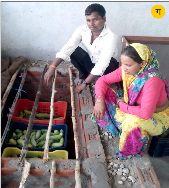
चित्र २४ : ईटाको पर्खाल र बाकस प्रकृतिको बाष्पिकरणिय चिस्यान (EC) क) ईटाको पर्खालको बाष्पिकरणिय चिस्यान ४.५ X २.५ X ०.६ मी लम्बाई, चौडाई र उँचाई, १५ - २० से.मी. ओसिलो दोहोरो पर्खाल (ख) भिजाएको बोराले छोपेको (ग) बाष्पिकरणिय चिस्यान भित्र राखेका तरकारीको अवस्था । घ) बाकस प्रकृतिको बाष्पिकरणिय चिस्यान १.३X०.९X२ मी लम्बाई, चौडाई र उँचाई, ओसिलो जुटको बोरा सहित
