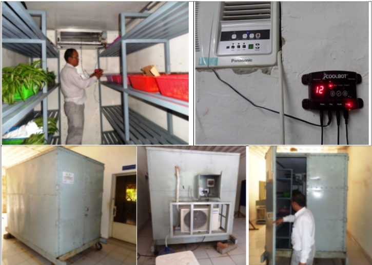
រូបភាពទី២០ ការស្តុកទុកក្នុងCoolbot ជាមួយនឹងឧបករណ៍ Coolbot ភ្ជាប់ជាមួយនឹងម៉ាស៊ីនត្រជាក់
